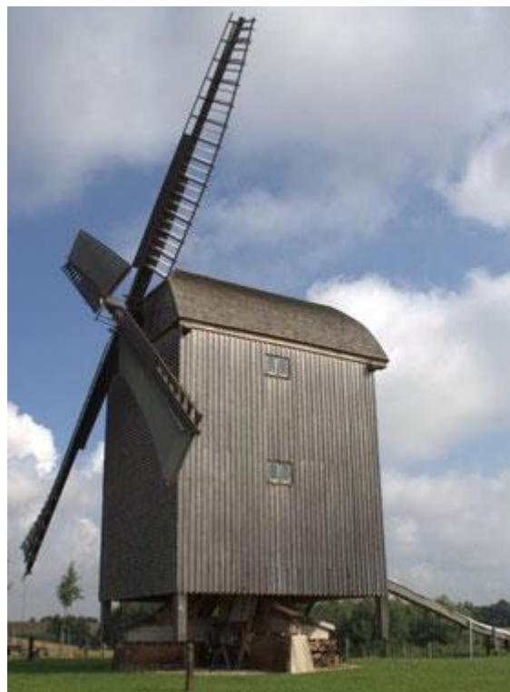
... in restauriertem Zustand heute (Bilder: Mühlenverein Storkow e.V.)
