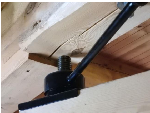
Um mit der Kranispindel an den Deckenbalken vorbei zu kommen ist Präzisionsarbeit erforderlich.
