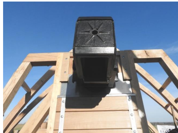
Ansicht der Kappe von vorn mit dem rekonstruierten Wellkopf.
