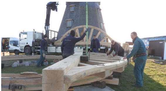
Hier wird der rechte Fugbalken auf die obere Rollbahn aufgesetzt.
