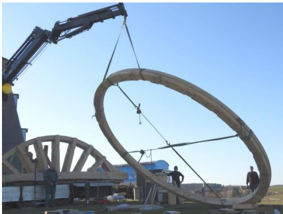
Nach der Montage der Laufbahnschienen, wurde der gesamte Ring umgedreht.
