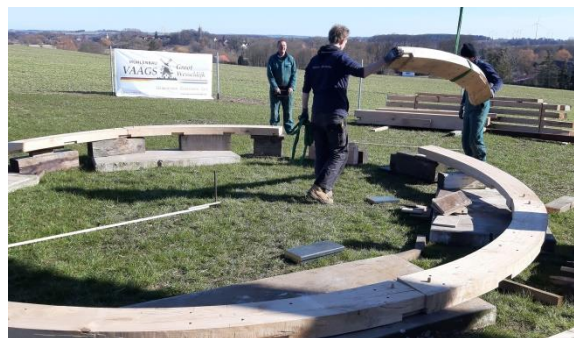
Die obere Laufbahn wird zusammengesetzt. Sie liegt hier noch mit der Lauffläche nach oben, damit ...
